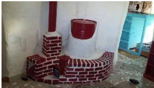
Diseño propio y Elaboración de Chimenea Ahorradora de leña, Tipo Rocket Stove con sistema de extracción de Bióxido de Carbono
