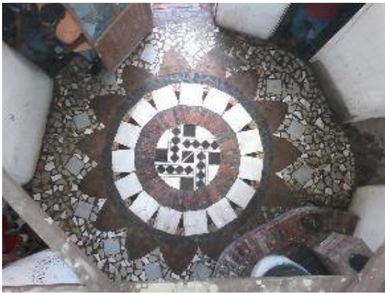
VISTAS DE ACABADOS EN PISOS INTERIORES COCINA, SALA Y BAÑO
