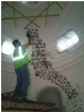
VISTAS DE ACABADOS EN MUROS INTERIORES
