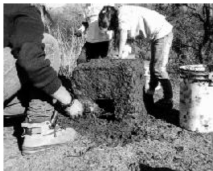
Construcción de un horno-rocket para la escuelita
