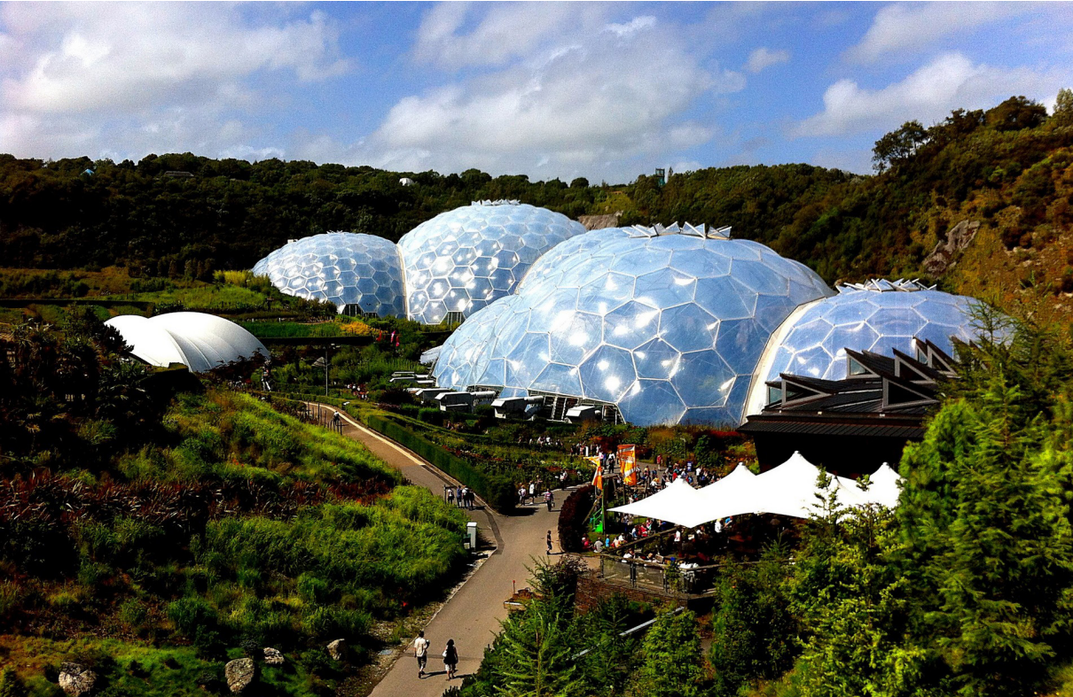
Domos en etil-tetra-fluoroetileno (ETFE) Proyecto Eden, Jardín botánico, Inglaterra Nicholas Grimshaw https://veredes.es/blog/eden-cornualles-nicholas-grimshaw-halldora-arnardottir-javier-sanchez-merina/
