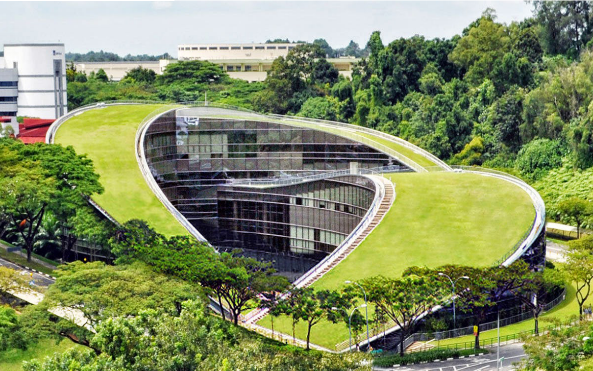
Ejemplo de Techo Verde: Escuela de Arte, Diseño y Medios de Comunicación (School of Art, Design & Media), Nanyang Technological University Campus, Singapur. https://flopme.com/green-roof-art-school-in-singapore/
